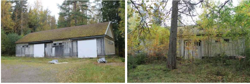
Vasemmalla autotallin eteläjulkisivu ja oikealla pohjoisjulkisivu.
