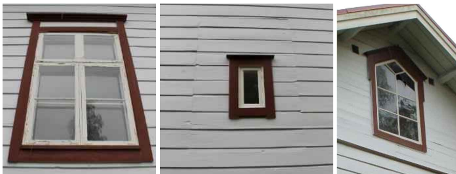
Johtolan ikkunat ovat pääosin 6-ruutuisia puuikkunoita (vasemmalla). Ikkunapuitteet ovat valkoiset ja ikkunalistat punaiset. Itäisellä julkisivulla toinen 6-ruutuistista ikkunoista on peitetty kokonaan ja toinen korvattu pienellä ikkunalla (keskellä). Ullakkokerroksessa on 7-ruutuiset ikkunat (oikealla).
