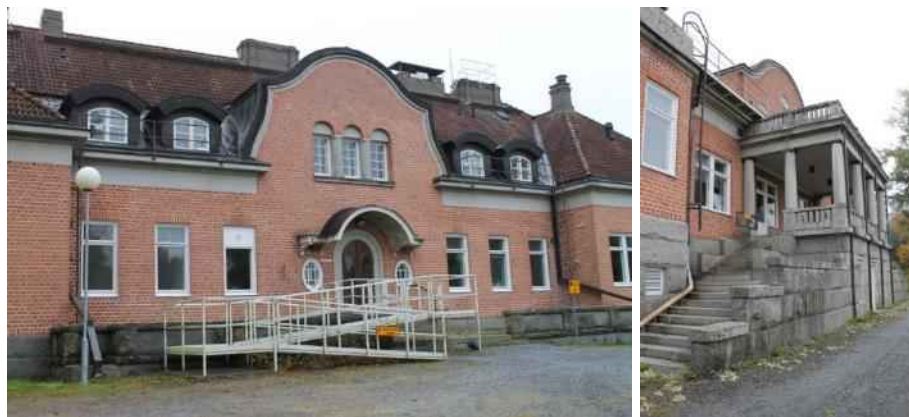
Vasemmalla on pääsisäänkäynti ja oikealla pihan puoleinen oleskeluterassi.
