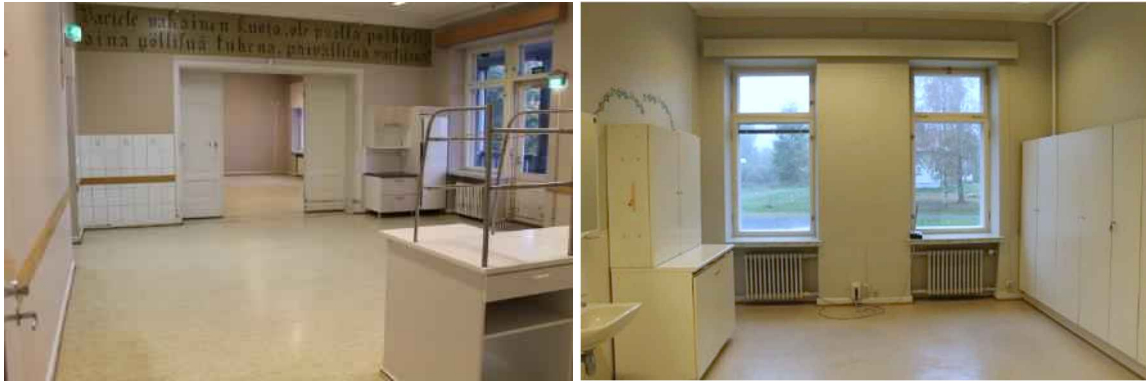
Vasemmalla on näkymä ruokasalista kohti olohuonetta ja oikealla etupihalle avautuva tutkimus/hoituhuone.
