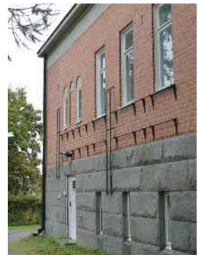
Itäjulkisivulla on paloportaat.
