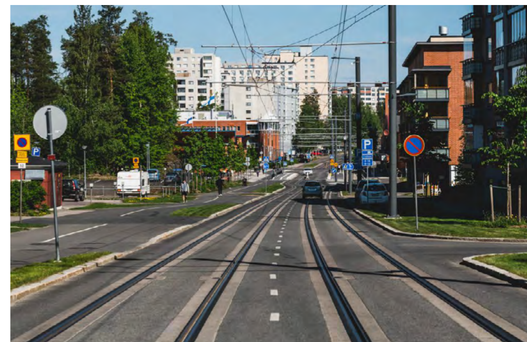
Kuva 51 Asfalttipintainen rata (kuva: Wille Nyysönen).
