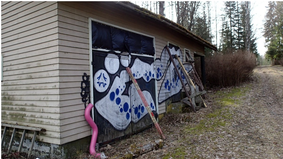
Kuva 10-10. Varastorakennus Alasjärven rannalla.
