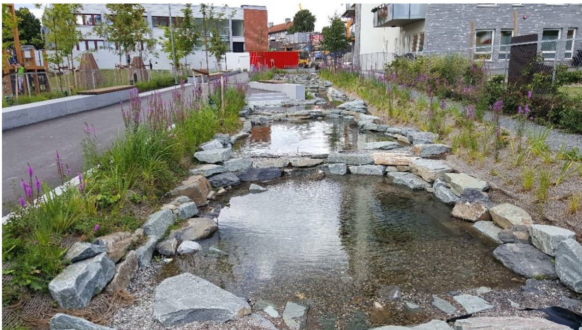
Kuva 4: Esimerkki painanteesta, johon on tehty pohjapatoja viivytyksen aikaansaamiseksi (Hatolan alueen hulevesiselvitys, Sitowise 2009)
