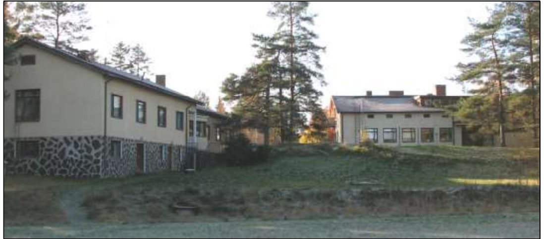
Kuva: oppilasasuntola Kipinä ja opistorakennus pohjoispuolelta kuvattuna.
